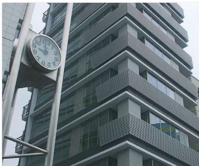
施工後（外壁横ルーバー）
