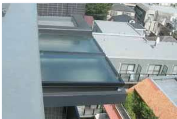
施工後（ガラス庇）
