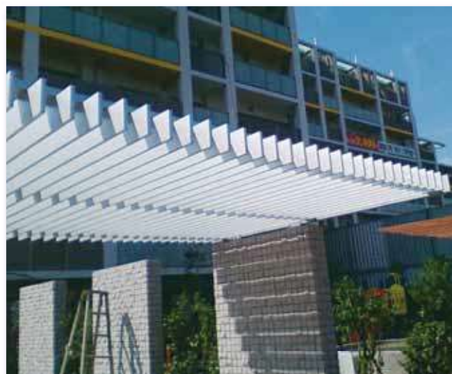
施工後（パーゴラ）
