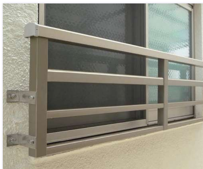
改修後（窓手摺）
