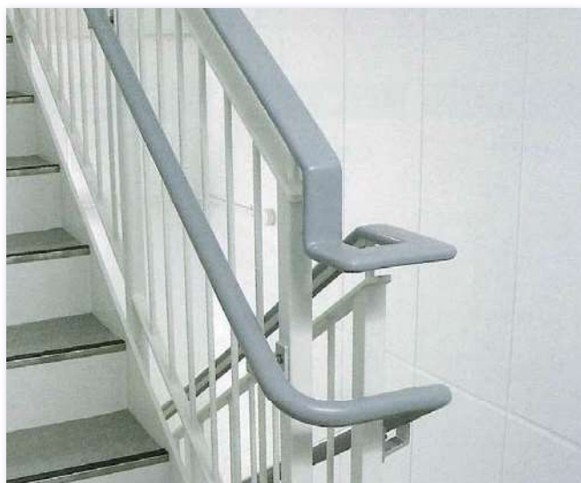
施工後（階段手摺ビニールハンドレール）
