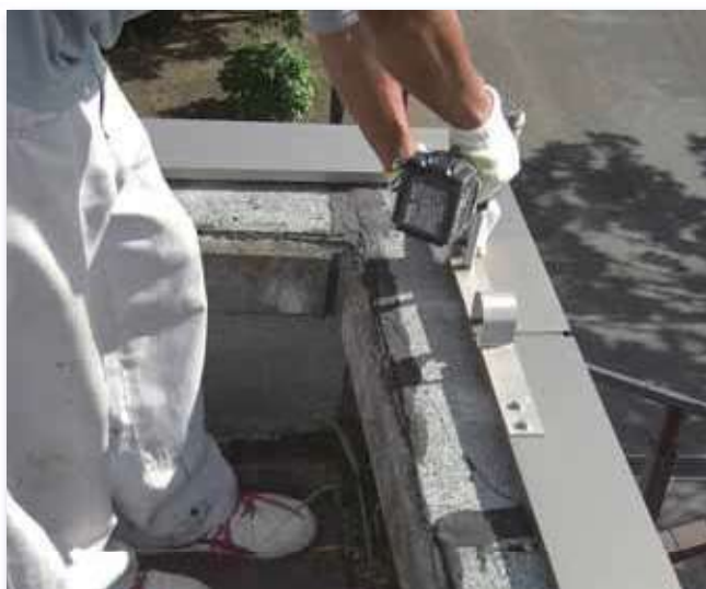
改修中（半笠木+むね上げ導体対応）
