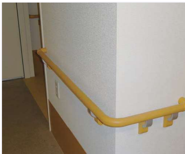
施工後（補助手摺）
