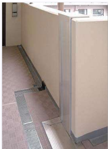
施工後（エキスパンションジョイントカバー）
