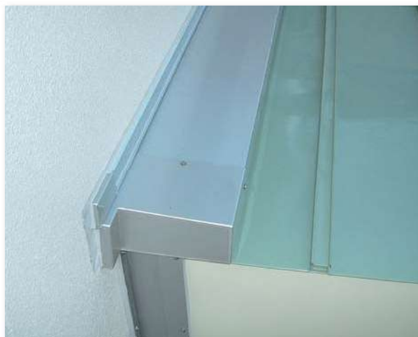
施工後（エキスパンションジョイントカバー）
