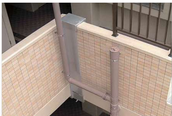
施工後（エキスパンションジョイントカバー）
