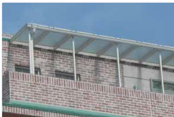
施工後（ガラス庇）
