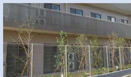
外構フェンス
