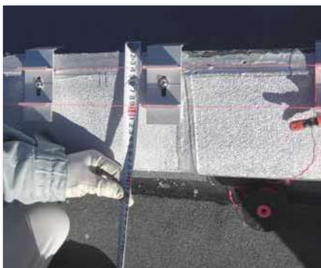
改修中（半笠木+むね上げ導体対応）
