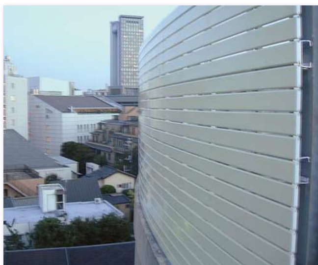
改修後（屋上ルーバー）
