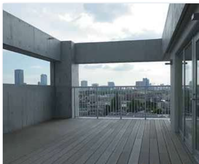
施工後（ウッドデッキ）
