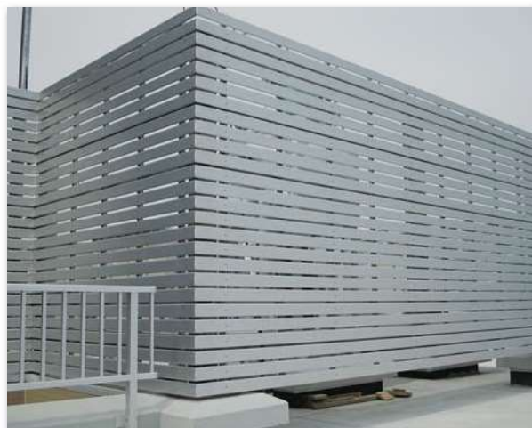
屋上ルーバー
