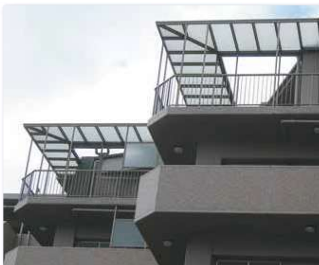
施工後（ガラス庇）
