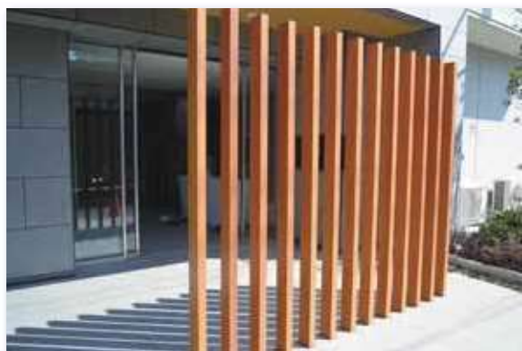
施工後（木目調ルーバー）
