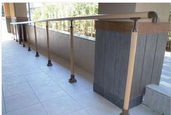
施工後（補助手摺）
