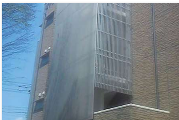
施工後（外壁縦ルーバー）
