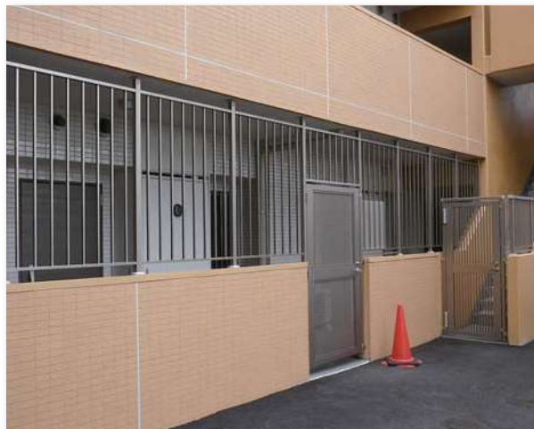
侵入防止柵+門扉
