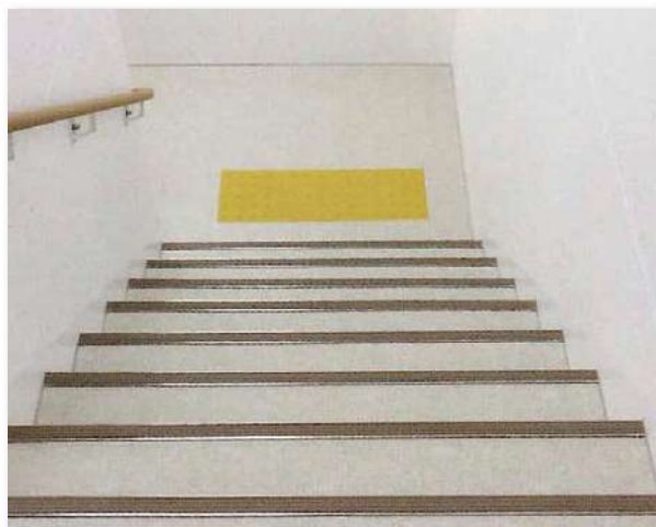
施工後（階段ノンスリップ）
