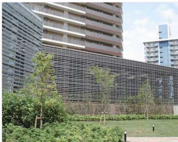
外壁ルーバー
