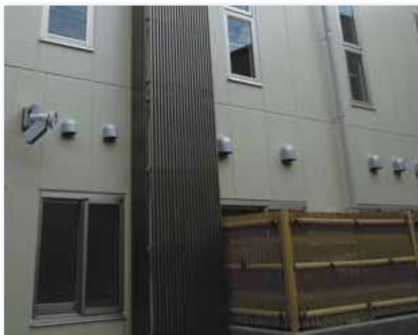
設備配管隠し
