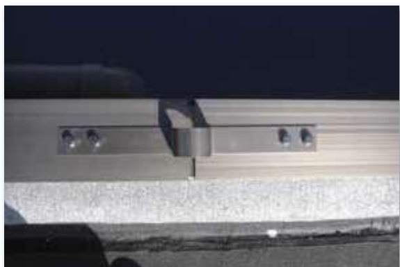
改修後（半笠木+むね上げ導体対応）
