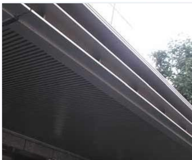
施工後（幕板+スパンドレル）
