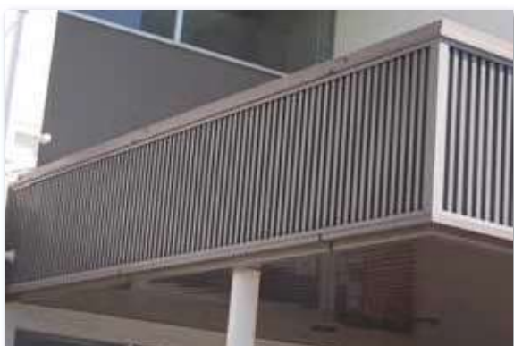
施工後（幕板+スパンドレル）
