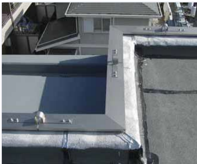
改修後（半笠木+むね上げ導体対応）
