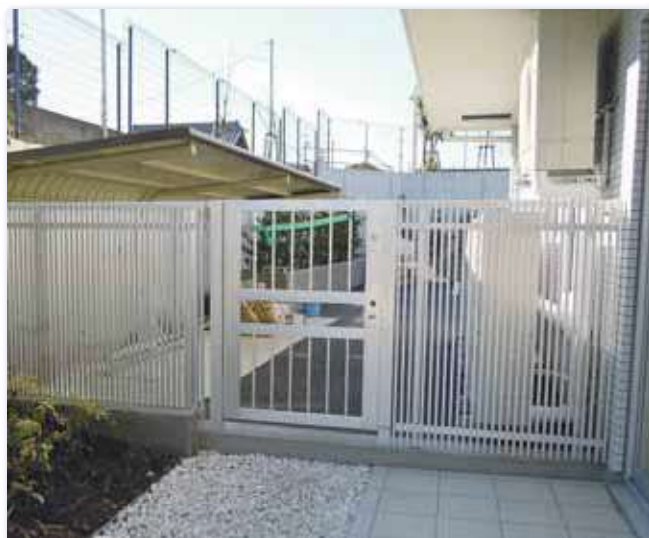
外構フェンス+門扉
