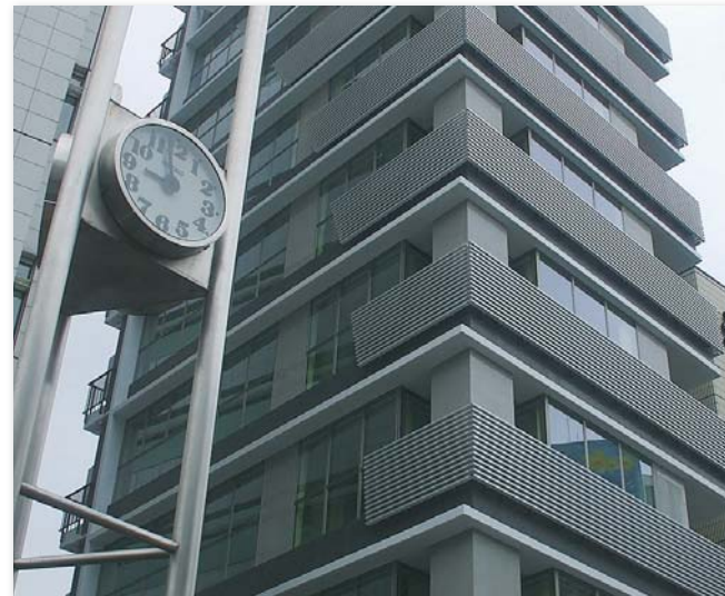
施工後（外壁横ルーバー）
