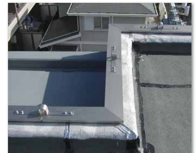
改修後（半笠木+むね上げ導体対応）
