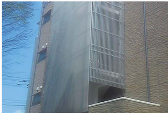
施工後（外壁縦ルーバー）
