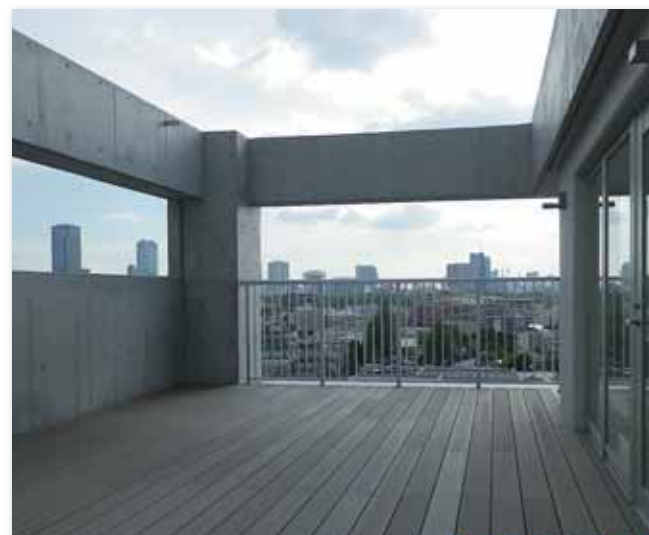
施工後（ウッドデッキ）
