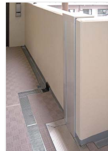
施工後（エキスパンションジョイントカバー）
