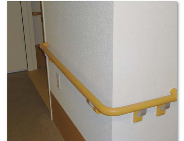
施工後（補助手摺）
