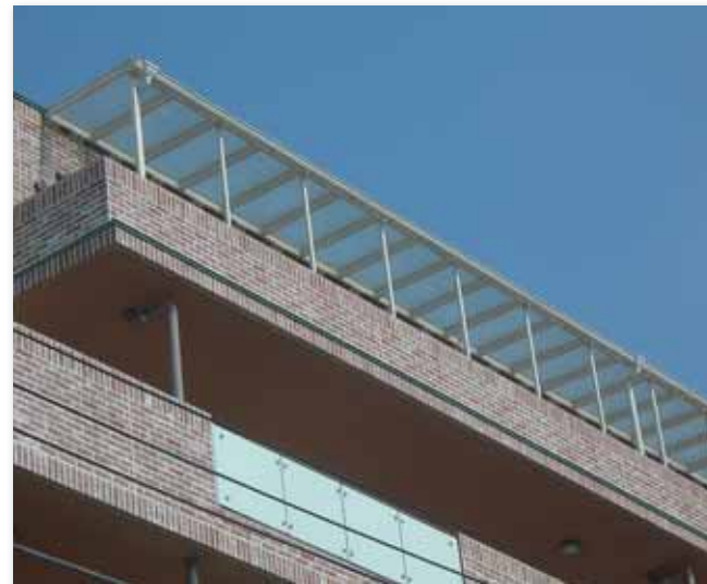
施工後（ガラス庇）
