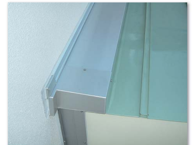
施工後（エキスパンションジョイントカバー）
