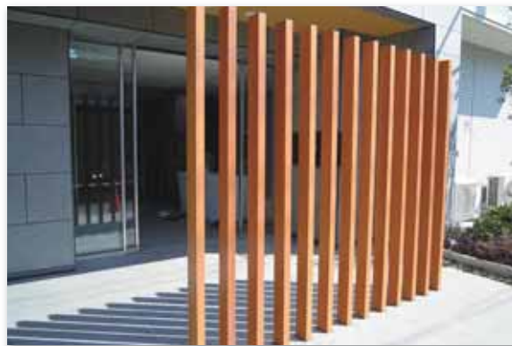
施工後（木目調ルーバー）
