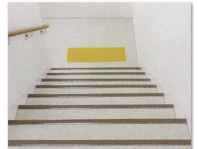
施工後（階段ノンスリップ）
