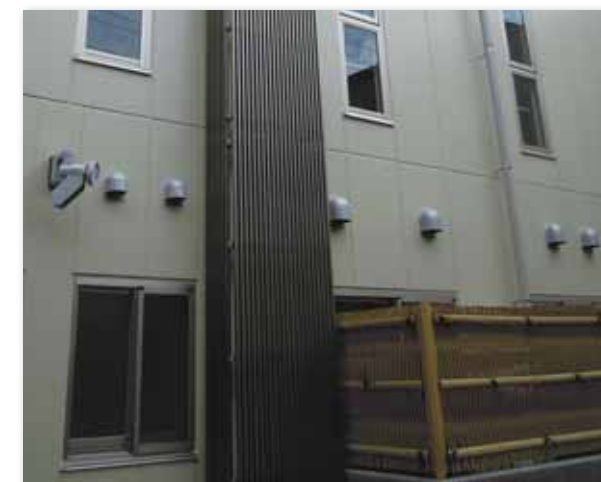
設備配管隠し
