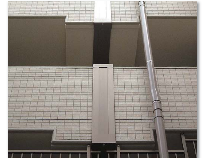
施工後（エキスパンションジョイントカバー）
