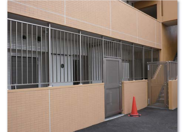
侵入防止柵+門扉
