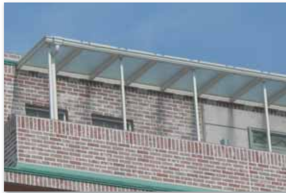
施工後（ガラス庇）
