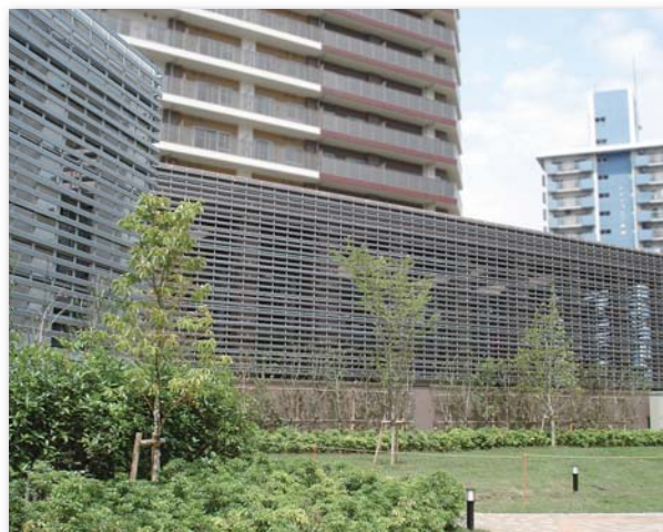
外壁ルーバー
