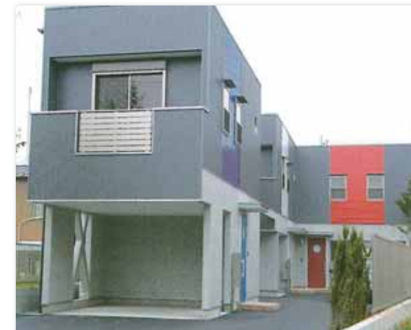
外壁スパンドレル
