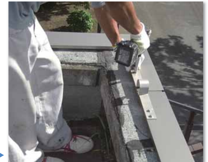
改修中（半笠木+むね上げ導体対応）
