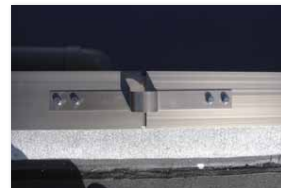
改修後（半笠木+むね上げ導体対応）
