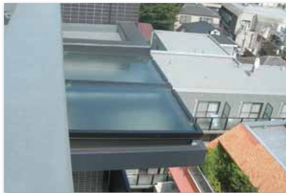
施工後（ガラス庇）
