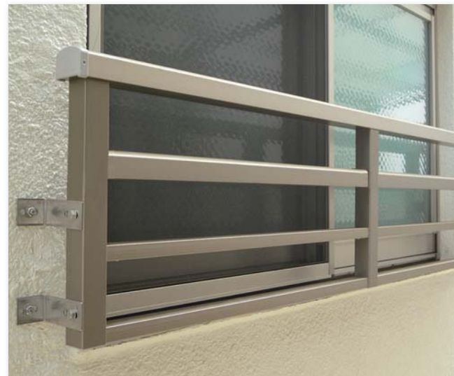
改修後（窓手摺）
