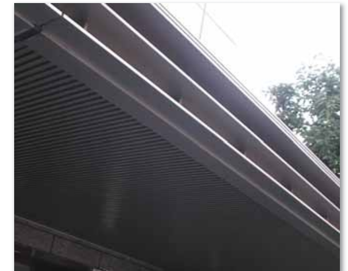
施工後（幕板+スパンドレル）
