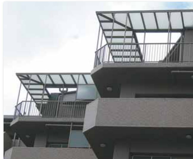
施工後（ガラス庇）
