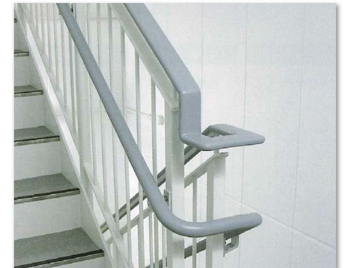
施工後（階段手摺ビニールハンドレール）
