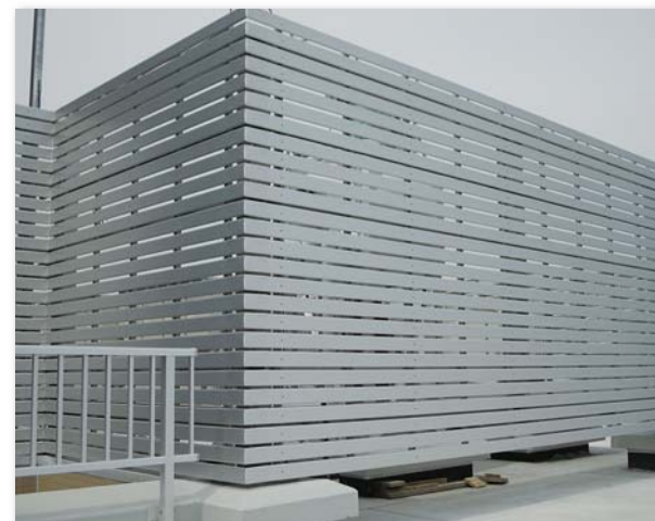
屋上ルーバー
