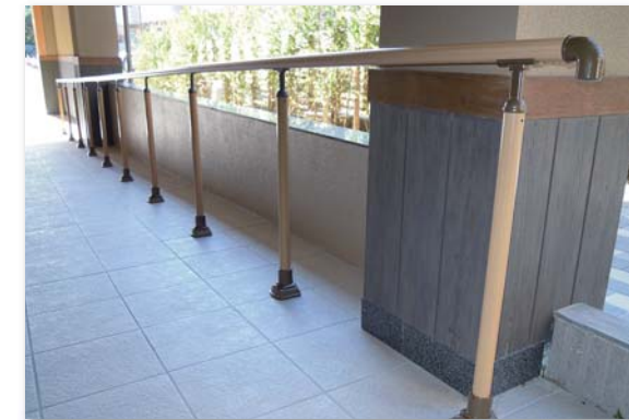
施工後（補助手摺）
