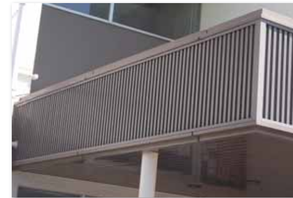
施工後（幕板+スパンドレル）
